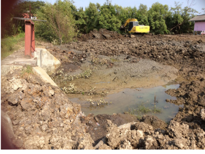
เริ่มปรับพื้นที่ถมดินป้องกันน้ำท่วม
