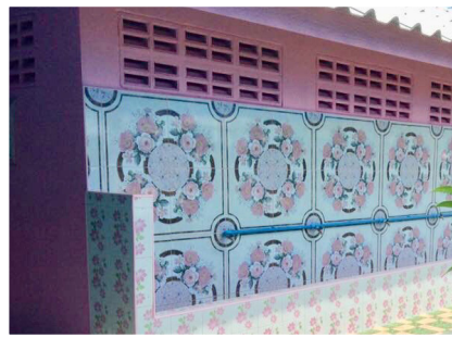
โรงเรียนสร้างห้องน้ำใหม่ให้นักเรียนอยู่ในจุดที่ปลอดภัย
